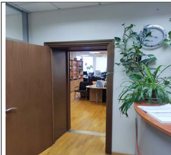
ФОТО № 11.Состояние внутренней отделки.
