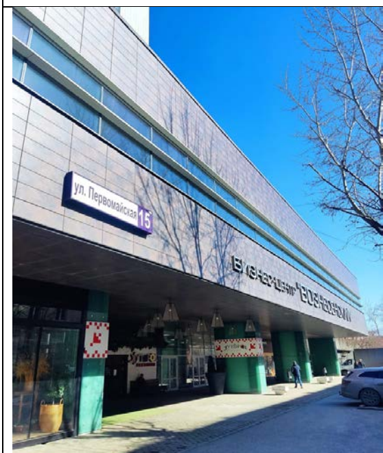
ФОТО № 13. Внешний вид здания.
