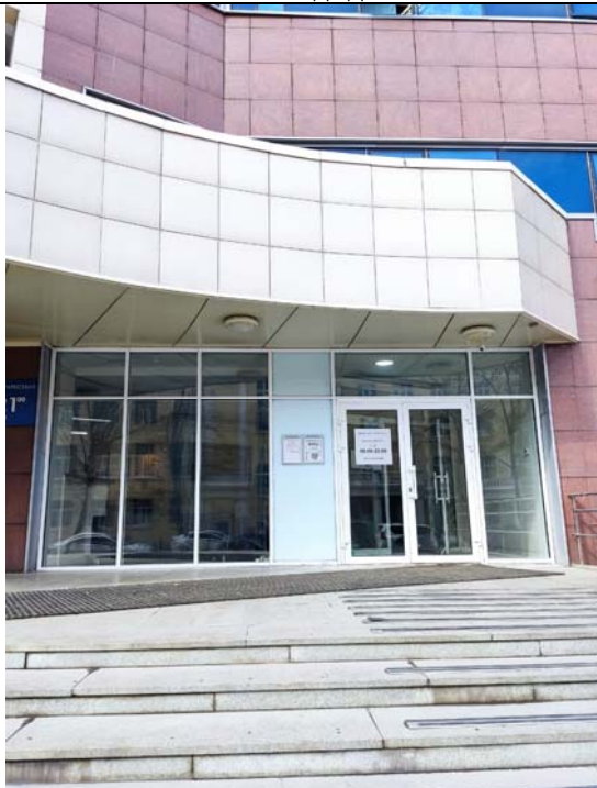
ФОТО № 3. Внешний вид здания.
