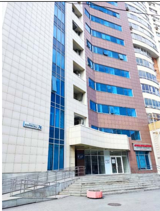
ФОТО № 2. Внешний вид здания.
