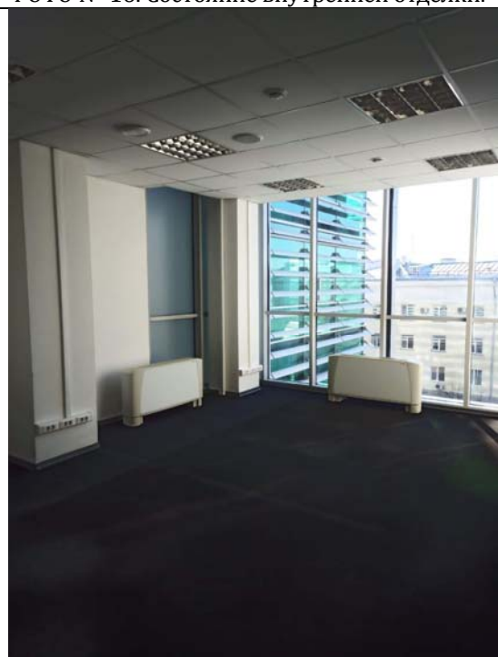
ФОТО № 18. Состояние внутренней отделки.
