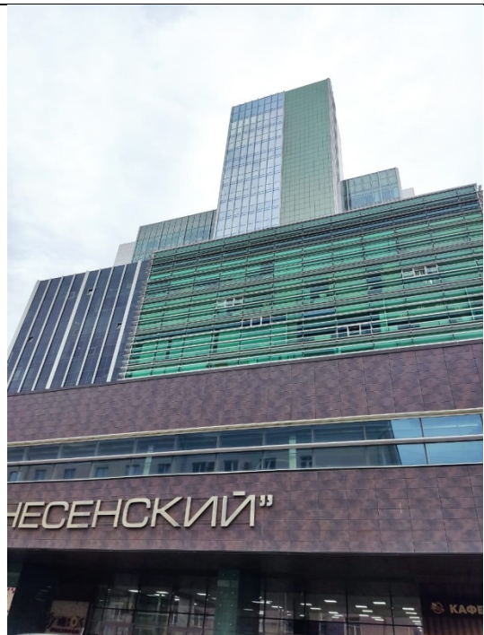
ФОТО № 11. Внешний вид здания.
