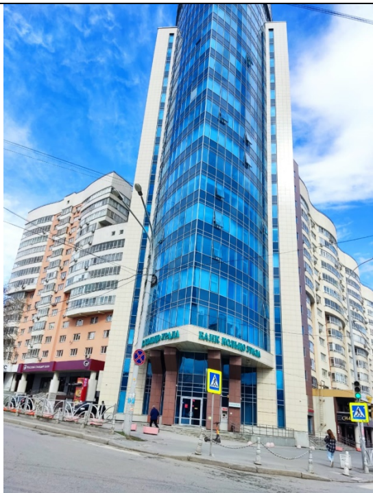
ФОТО № 1. Внешний вид здания.
