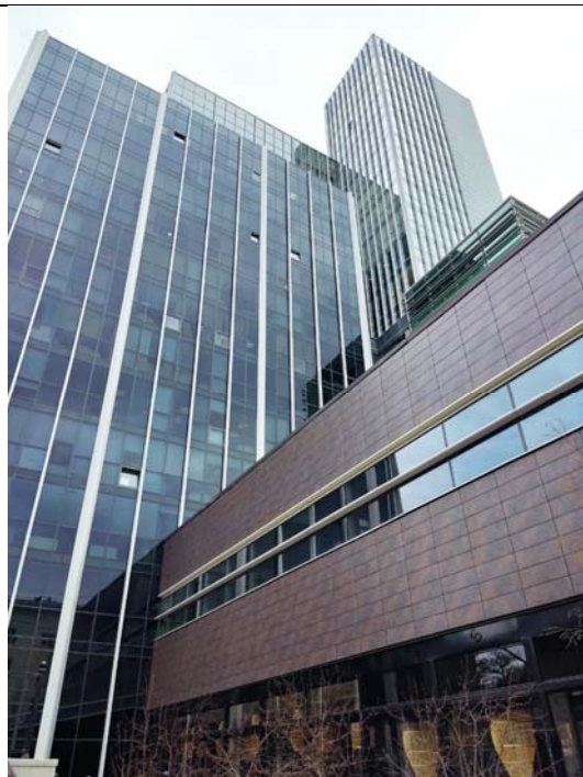
ФОТО № 12. Внешний вид здания.
