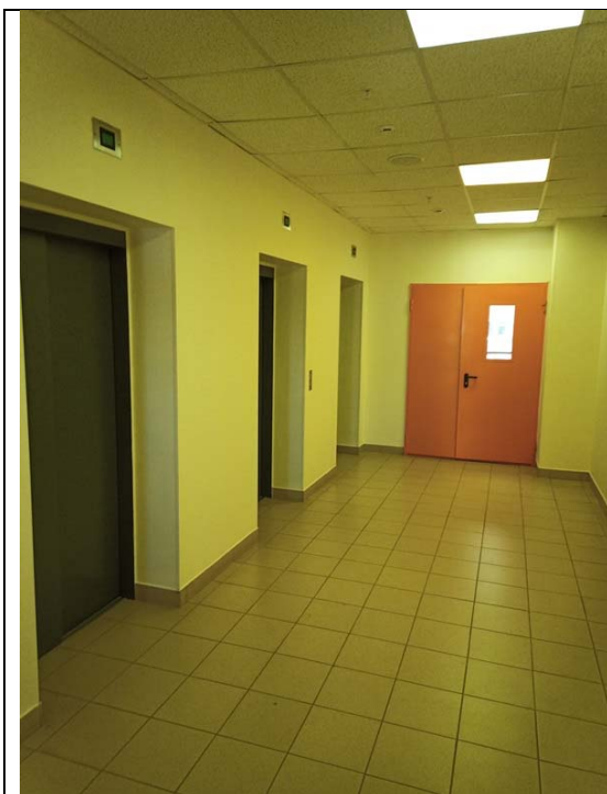
ФОТО № 9. Состояние внутренней отделки.
