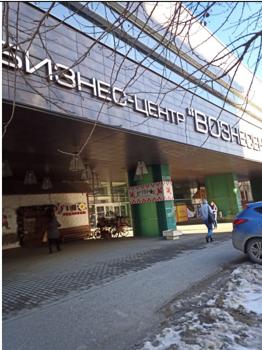
ФОТО № 8. Внешний вид здания.
