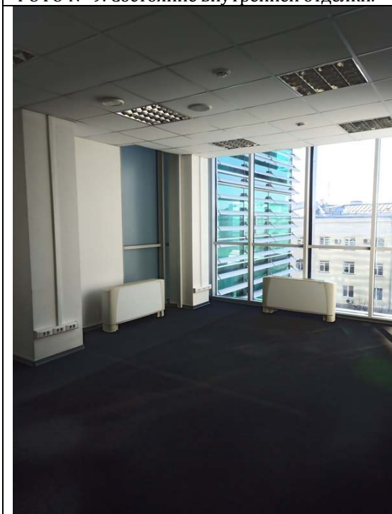
ФОТО № 11. Состояние внутренней отделки.
