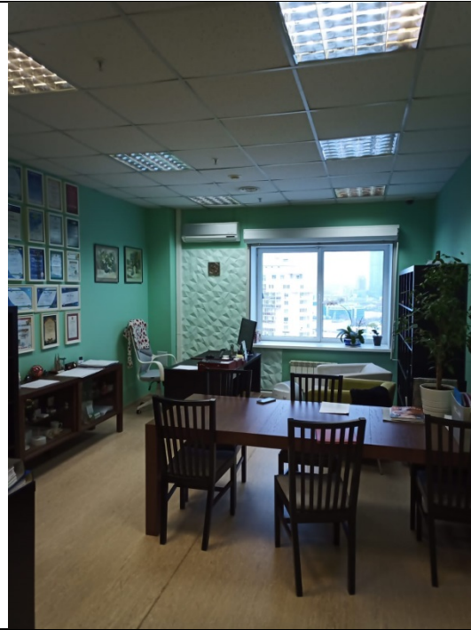
ФОТО № 6. Состояние внутренней отделки.
