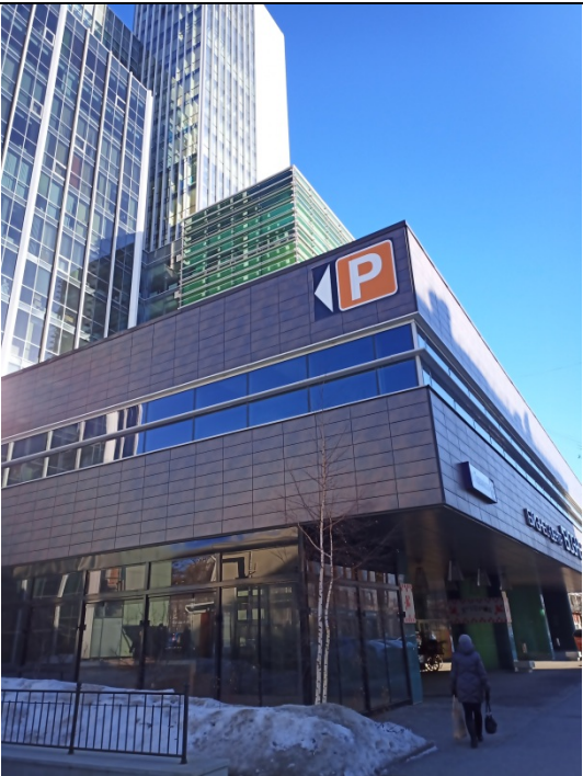
ФОТО № 7. Внешний вид здания.
