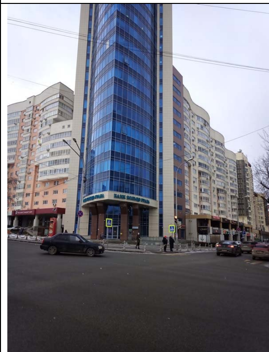
ФОТО № 1. Внешний вид здания.
