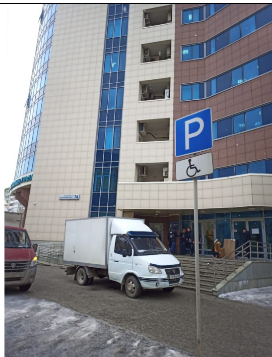
ФОТО № 2. Внешний вид здания.
