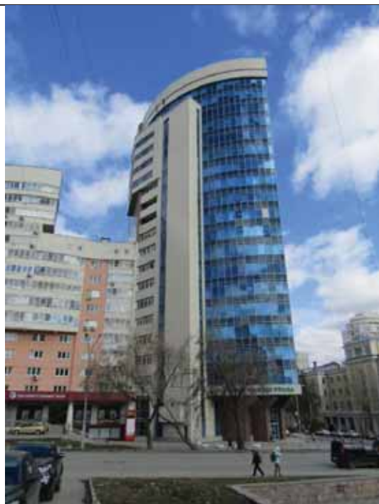
ФОТО № 1. Внешний вид здания
