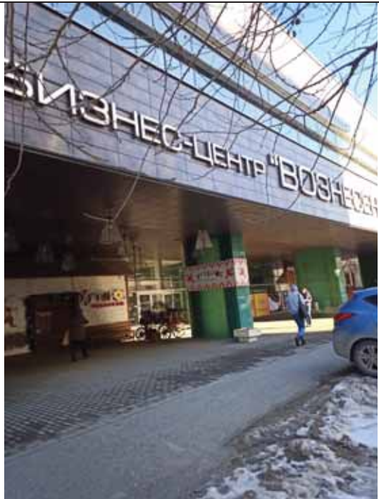
ФОТО № 8.Внешний вид здания
