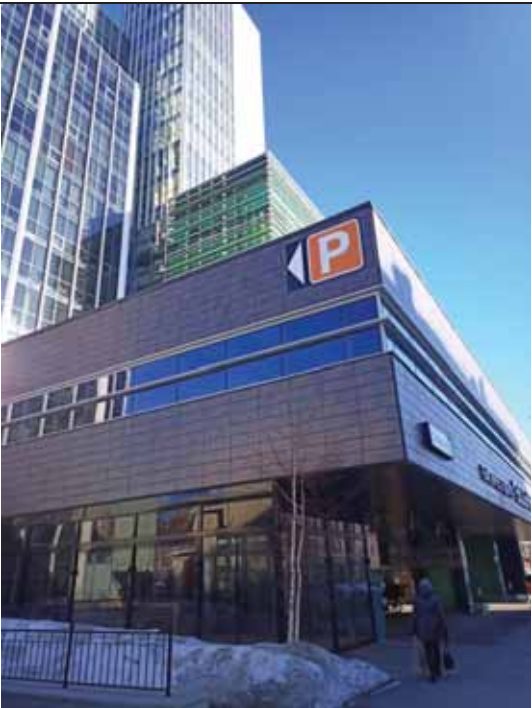
ФОТО № 7.Внешний вид здания
