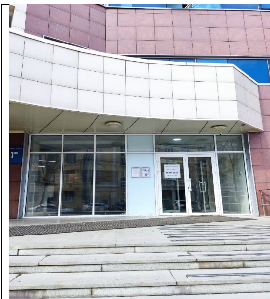
ФОТО № 3. Внешний вид здания.
