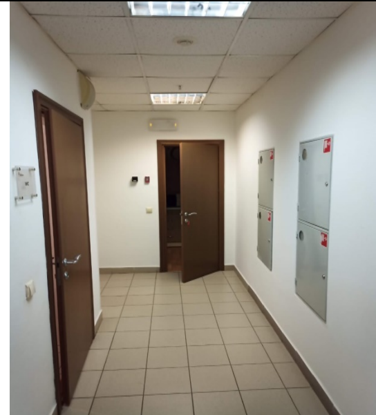
ФОТО № 7. Состояние внутренней отделки.
