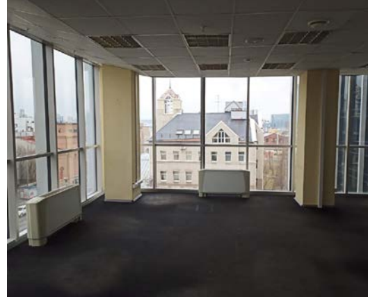
ФОТО № 14. Состояние внутренней отделки.
